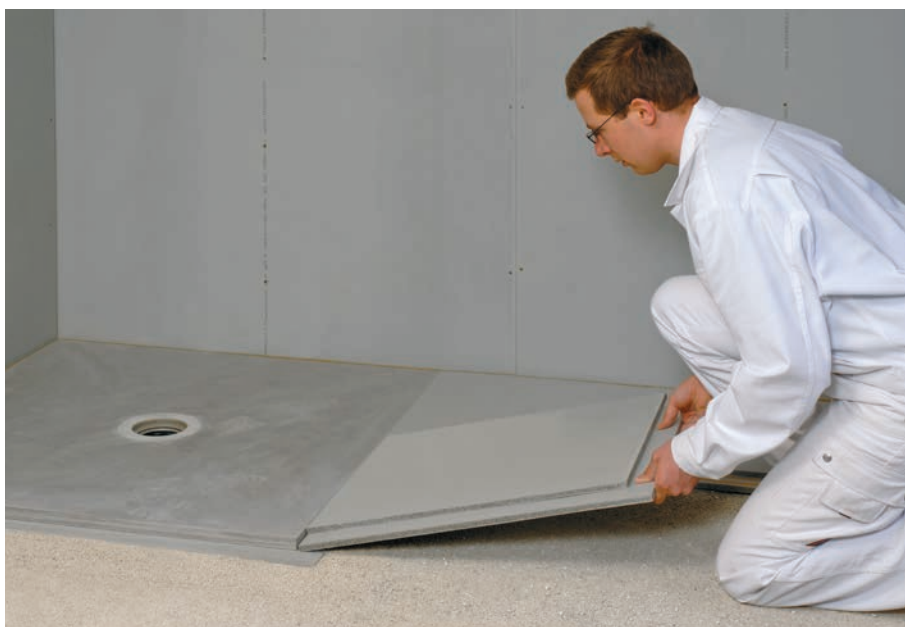
Exemple d'un élément de douche à l'italienne 1000 mm×1000 mm. Cotes en mm
